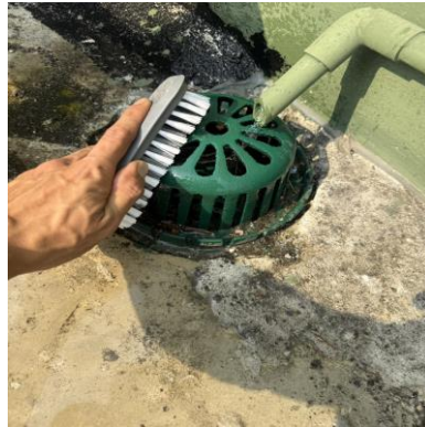
ภาพที่ 2.1-12 ตรวจสอบทำความสะอาดระบบระบายน้ำ
